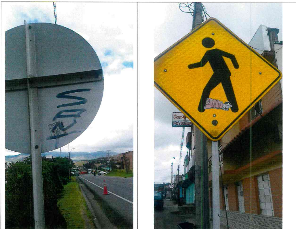
Señales afectadas por vandalismo alrededor de la I.E. Nuestra Señora de Guadalupe
