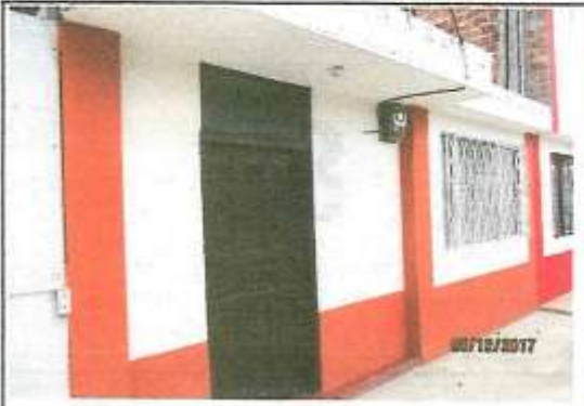
Fachada de vivienda ubicada en barrio La Frontera en la ciudad de Ipiales, Vivienda de un nivel y terraza que se encuentra en similares condiciones a las encontradas el día 20 de diciembre de 2016 y registradas en el acta 015.
