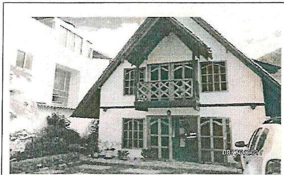
Foto 2. Fachada interna muros en placas prefabricadas con vigas en madera.
