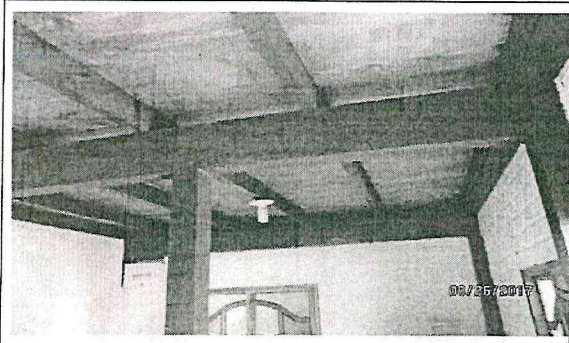
Foto 8. Techo losa en concreto, soportado en estructura de madera
