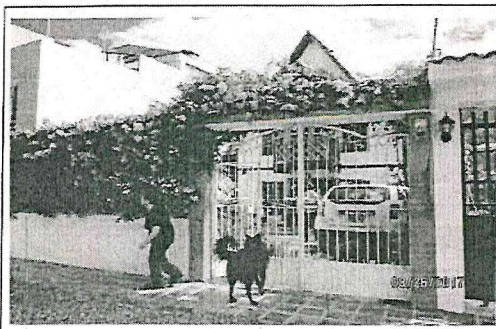
Foto 1. Fachada externa con muro medio en ladrillo con cerramiento en reja.
