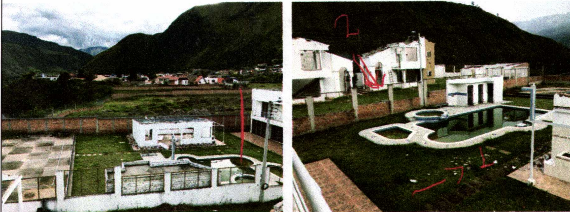
VISTA DEL PREDIO DE LA PARTE QUE SE AFECTA Y QUE SE DEMUELE Y SE REALIZA EL CORTE DEL TALUD
