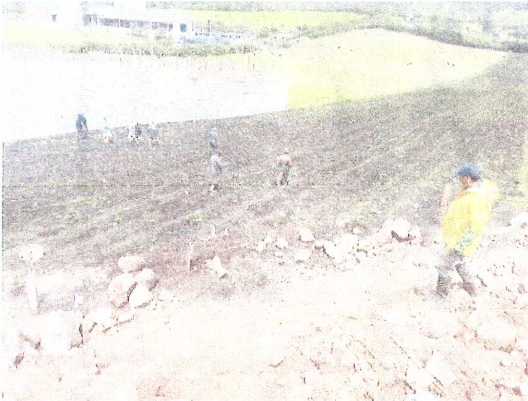
JORNALEROS, ADECUANDO EL TERRENO INUNDADO
