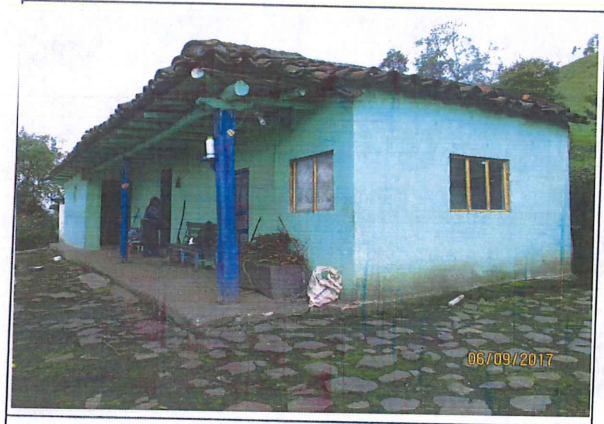
Fachada del predio, vivienda de un piso construida con muros en ladrillo macizo con repello y pintura, cubierta total en teja de barro soportada en estructura de madera
