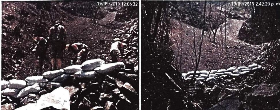
Se realiza construcción de barrera en sacosuelos, a fin de prevenir que el material suelto pueda desprender hacia la parte baja de la fuente.
