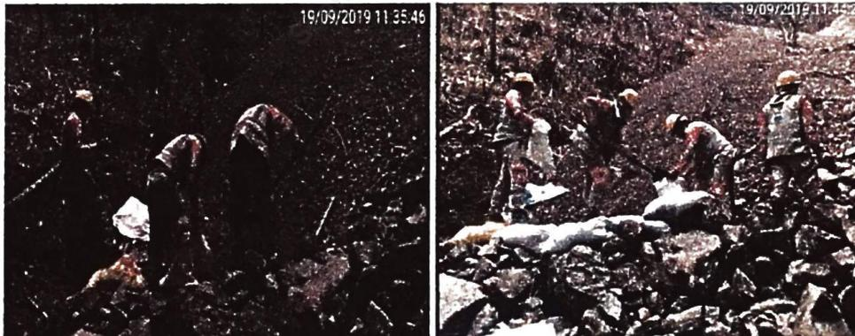
Retiro de material de excavación que cayó sobre la fuente, con el fin de prevenir posibles obstrucciones y colapso de la fuente hídrica.
