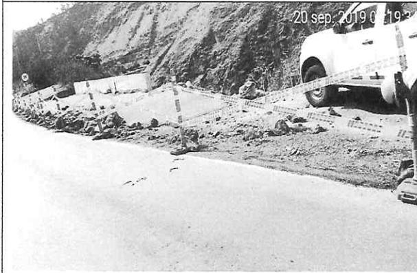
Delimitación con dispositivos viales y señalización horizontal línea de borde y línea de eje
