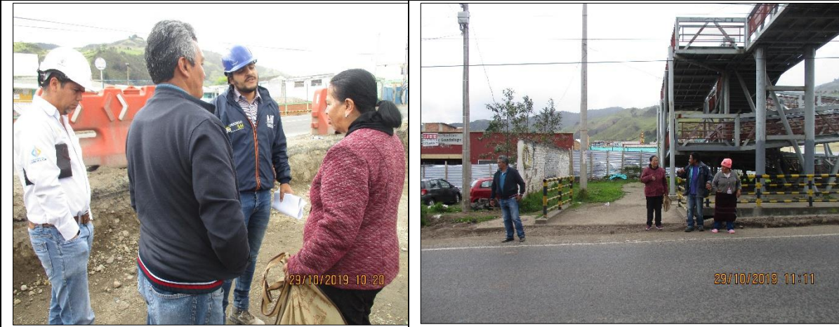
Se informó que se construirá un canal en concreto de 1.5 x 1.5 con capacidad hidráulica suficiente para conducir las aguas de escorrentía.
