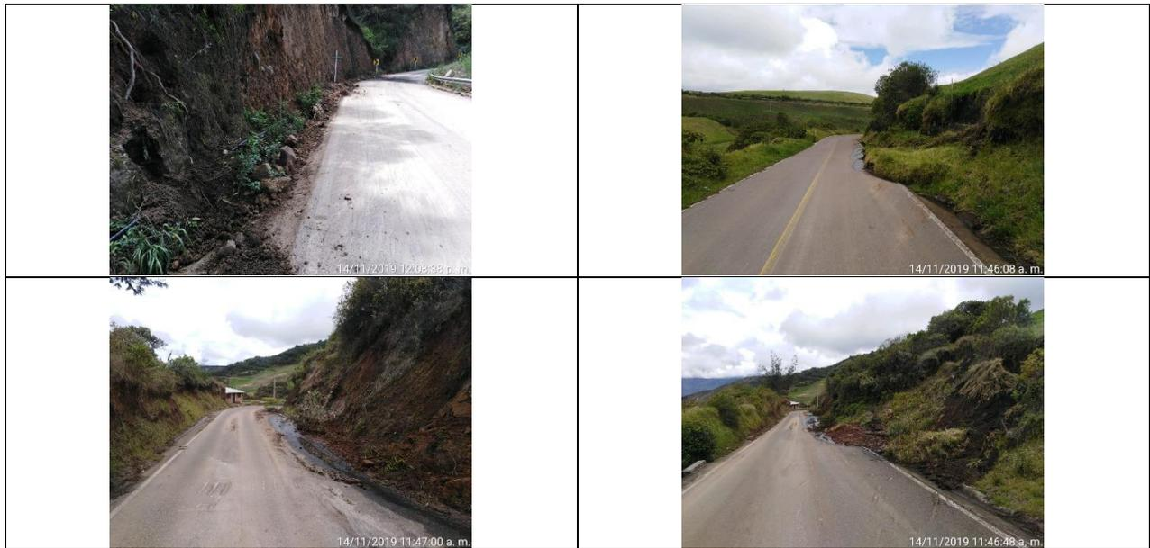
3. Falta de mantenimiento y limpieza de la vía que de la Panamericana conduce al Municipio de Iles.
