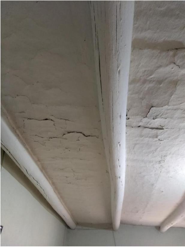
Presencia de goteras y agrietamiento de cielo raso
