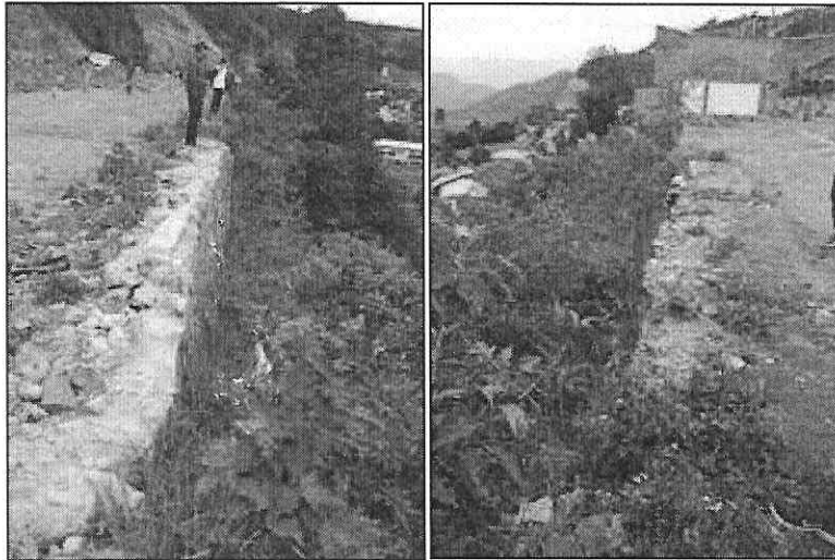
Muros construidos anteriormente por los propietarios de las viviendas demolidas en la parte alta.
