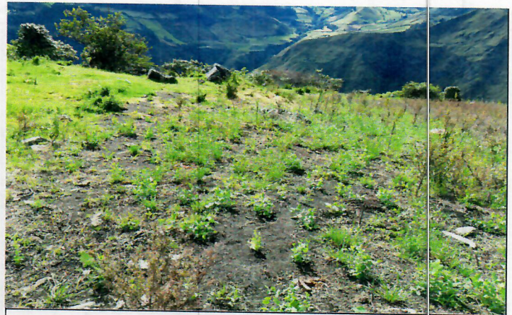
Sedimentos arrastrados por escorrentías.
