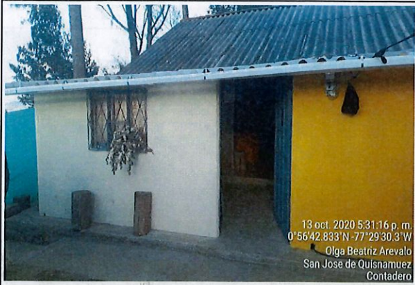
Identificación de fachada frontal de la vivienda, la cual cuenta con muros en tapia y acabados en repello y pintura.
