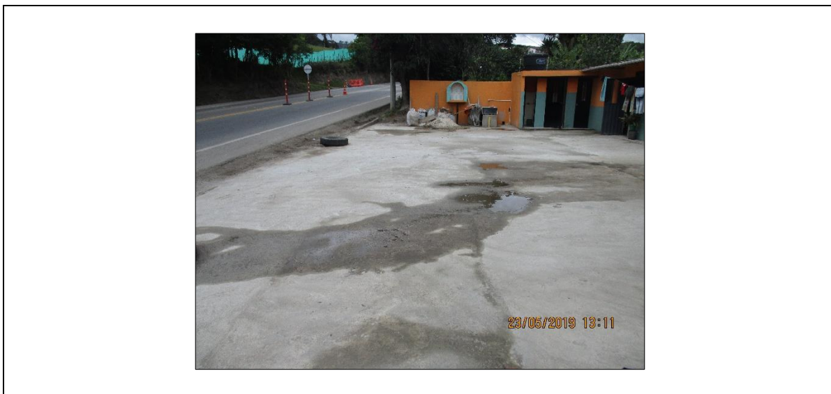
Se realizó el cierre de la GASAU 0019-19 del sr. Fabio Leguizamo por la reparación del patio de su vivienda.
