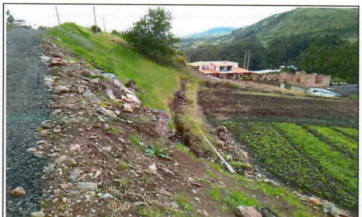
Descole de alcantarilla que pasa por parte superior del predio, actualmente ya esta debidamente canalizado
