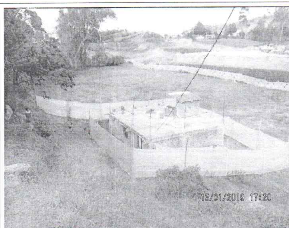
Instalación de polisombra en los linderos de la vivienda de la señora Viviana Cabrera.
