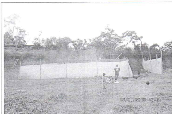
Instalación de polisombra en los linderos de la vivienda de la señora Viviana Cabrera.
