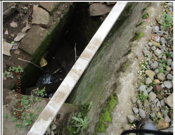
20-02-19. Vereda la Merced. Cajilla de alcantarilla, ubicada en la zona frontal del predio de la peticionaria.
