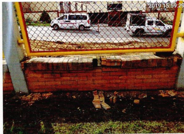
**Descripción:** Muro frontal del predio con desprendimiento de piezas de ladrillo, debido al presunto impacto del mini-cargador que realizaba labores para la doble calzada en el corredor vial.
