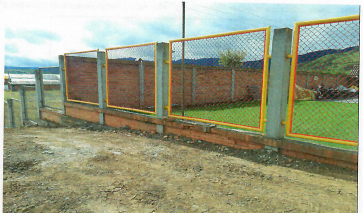
Cerramiento, muro en mampostería de ladrillo, columnas de confinamiento en concreto reforzado y mallas eslabonadas con marcos cilindricos metálicos.
