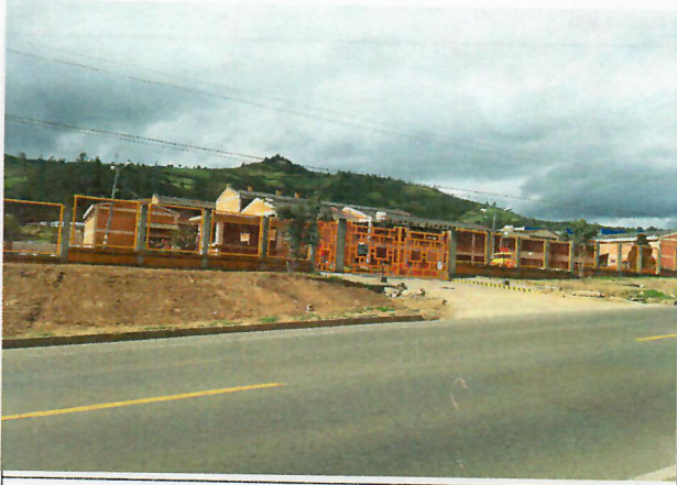
Fachada y vista frontal del cerramiento.
