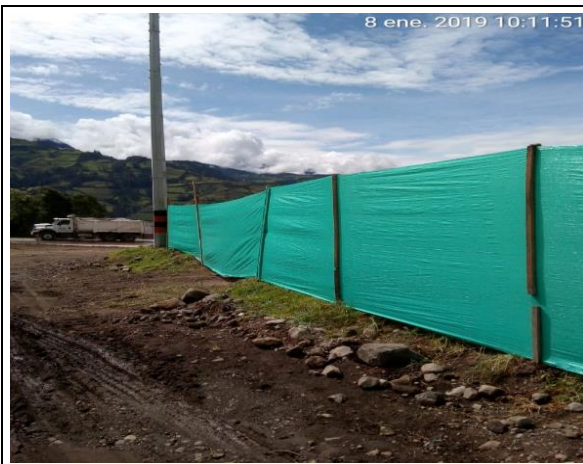
Instalación de polisombra en la vivienda de la peticionaria, ubicada en PR 14+450.
