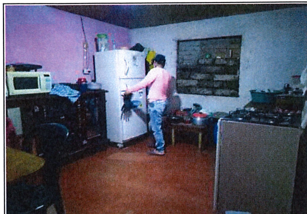
Cocina 1, propietaria manifiesta grietas y fisuras en todos los muros y además dilatación o grietas en unión de muros con piso, según el acta inicial estas no son afectaciones recientes
