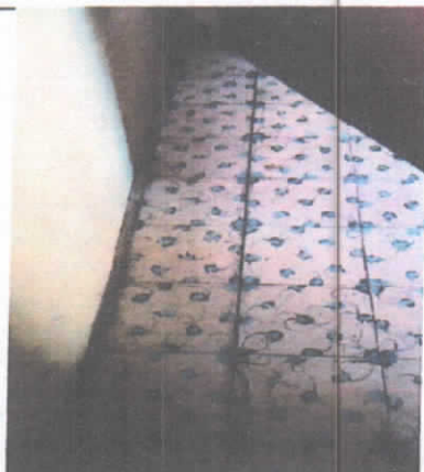
El piso de la sala se registra con una junta de separación, en la zona posterior.
