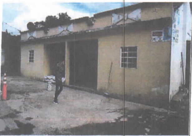
Fachada principal de la vivienda a la que se realiza acta de seguimiento. La vivienda es de un solo piso, construida en ladrillo y adobe. La cubierta es en tejado de barro.
