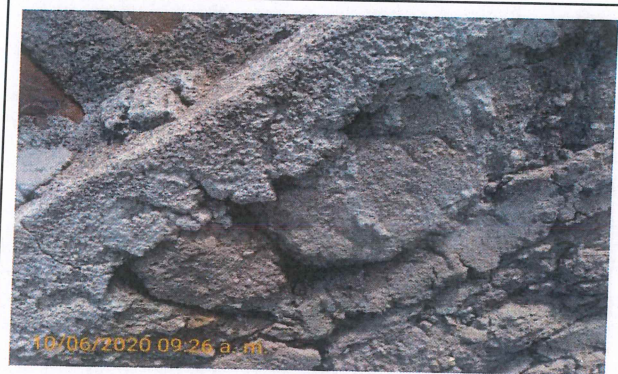
FOTO 4. desprendimiento de repello en muro de cerramiento.
