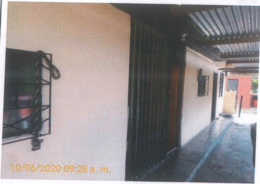
FOTO 1. Fachada frontal de la vivienda.
