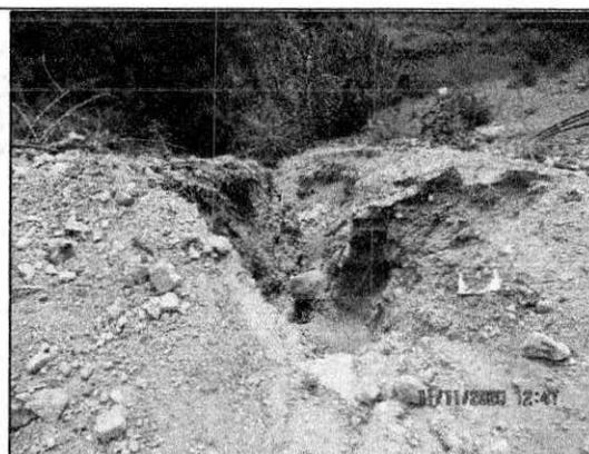
Cárcava en predio del sr Azael Romero, causado por inadecuado manejo de aguas
