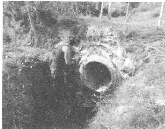
Tubería para descole de alcantarillado en interferencia con la red mencionada por el peticionario
