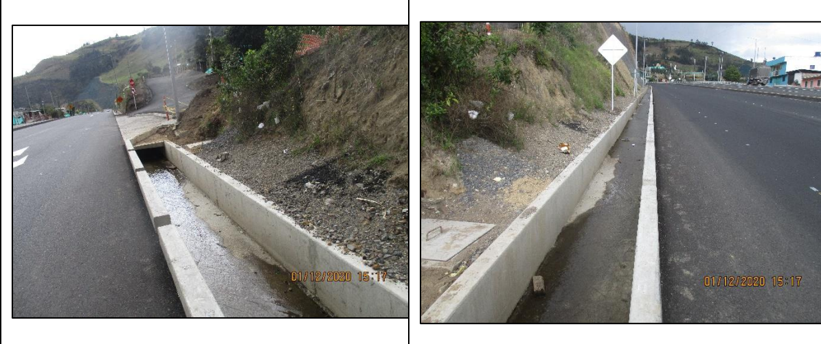
“Canaleta” o canal de guarda construido y en normal funcionamiento
