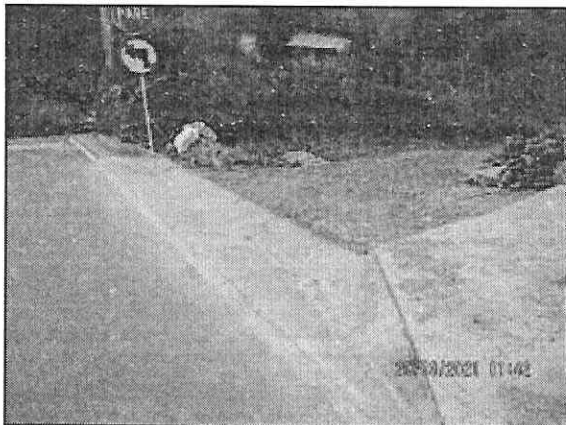
Construcción de la cuneta en el acceso a la gruta
