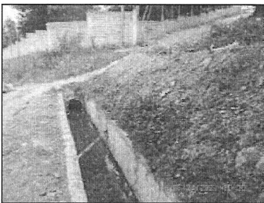
Punto que finaliza la construcción del canal
