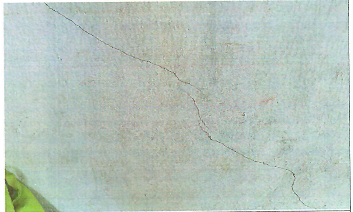
Propietario manifiesta fisuramiento en el muro lateral derecho de la cocina, debido a vibraciones generadas por el tránsito de volquetas, esta fisura se refleja en ambas caras del muro.
