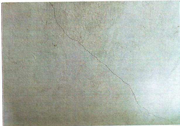
Propietario manifiesta fisuramiento en el muro lateral derecho de la cocina, debido a vibraciones generadas por el tránsito de volquetas, esta fisura se refleja en ambas caras del muro.
