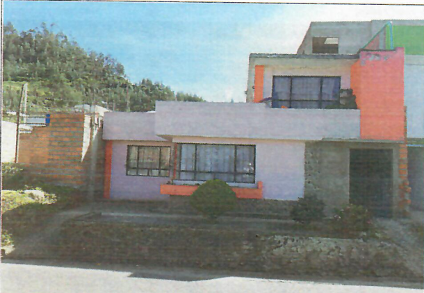
Fachada de la vivienda.
