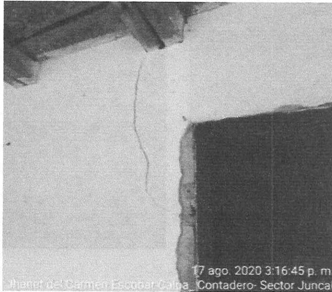
3. Fisura transversal en habitación 1 pared del costado lateral derecho que se extiende desde el cielo raso hasta la mitad de la pared
