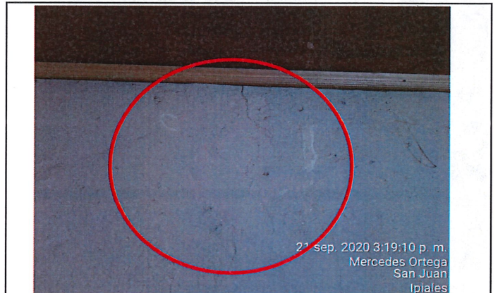
Cocina en el segundo nivel de la vivienda: se evidencia fisuras en muro lateral derecho transversales y longitudinales, estas son superficiales en repello y pintura.
