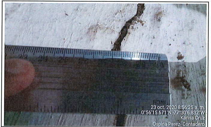
Bodega 1: se observa grieta en muro lateral derecho de tipo longitudinal y transversal esta cuenta con un espesor de 5 mm
