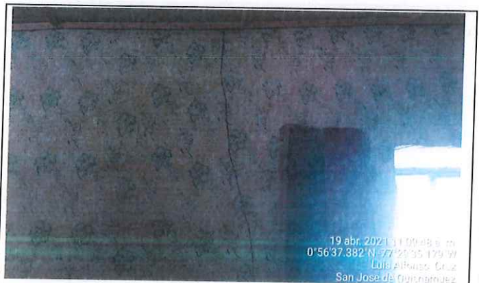
Habitacion 1. se observa en muro lateral izquierdo fisura longitudinal en zona central, así como dilatación en esquinas de muros
