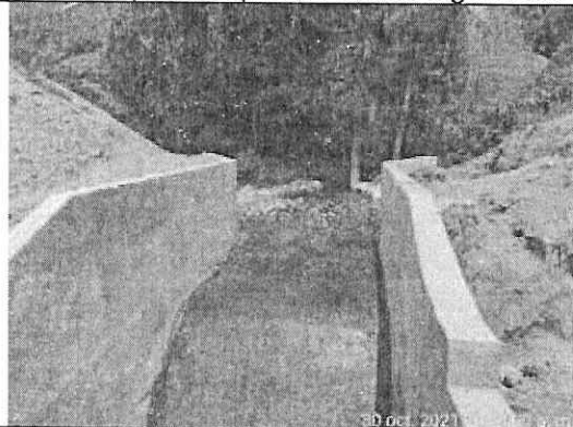
Foto 1. Estructura de encole y obra hidráulica tipo Box Culvert construida para el paso sobre la fuente hídrica
