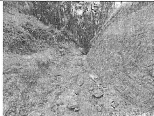
Foto 4. Salida o descole de la obra hidráulica Quebrada Yamurayan
