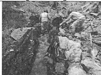
Foto 6. Instalación de plástico en el descole de la tubería ubicada para el paso provisional sobre la Q. San Francisco
