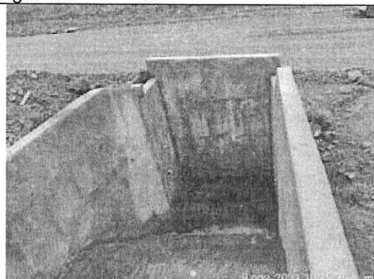
Foto 2. Obra hidráulica tipo Box Culvert Q. Yamurayan
