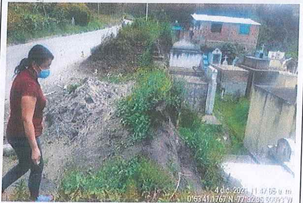
Identificación de muro en tapia
