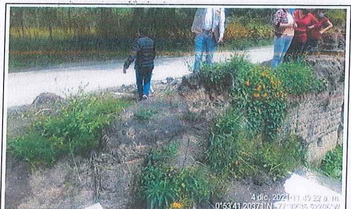
Altura promedio de muro 0.6m
