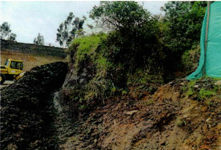
**IMAGEN PLANO MEDIO N° 6.** En la imagen se aprecia canaleta en piedra para adelantar fundición de concreto, esta obra se realiza al pie del yacimiento de agua perdido por causas de las obras de construcción de la vía panamericana.
