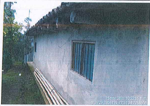
Identificación de fachada lateral izquierda de vivienda, acabado en repello y cubierta con tejas de barro
