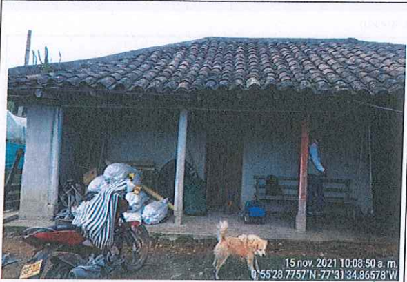
Identificación de fachada frontal de vivienda, acabado en repello y cubierta con tejas de barro
