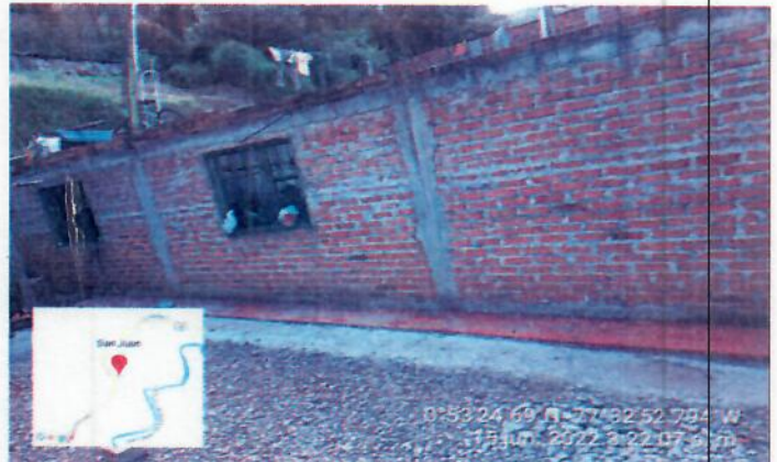
Fachada lateral izquierda de la vivienda.
