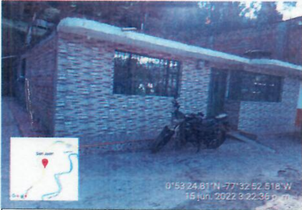
Fachada frontal de la vivienda.
