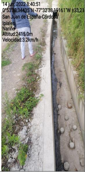
Identificación de obra de drenaje que se construyo a solicitud de los habitantes del sector, al momento de la visita se encuentra el canal en optimo funcionamiento, no se observa afectación debido a esta obra de canalización de aguas lluvias.
