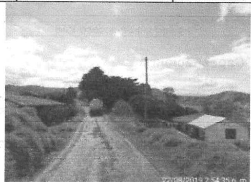
Humectación vía de acceso VA5
