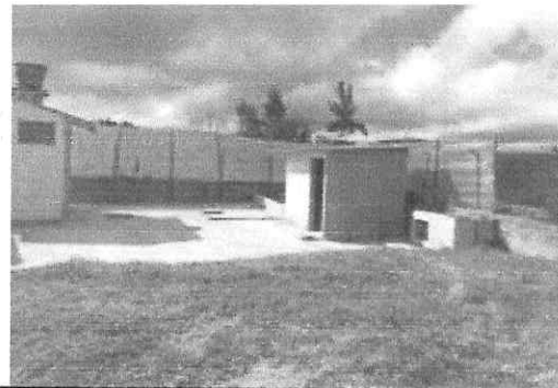
Cerramiento viviendas sector Urbano
