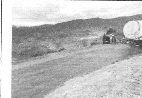
Humectación vía de acceso VA5
