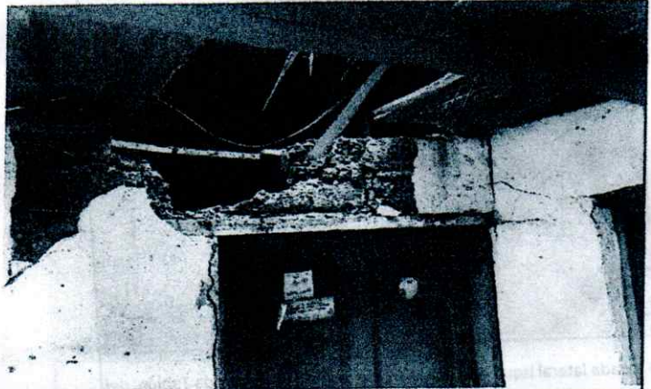
Propietario manifiesta desplome parcial del dintel ubicado en la puerta de acceso a la habitación 1, debido al golpe de una roca desplazada de obras de corte en el sector.
