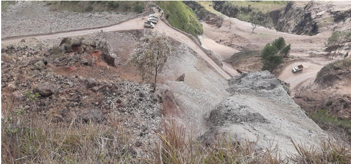
Área que albergaba bosque nativo, totalmente destruido por los escombros ocasionados por las voladuras en terrenos aledaños al predio.
