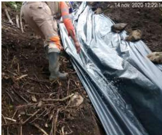
**Fotografía No 3.** Instalación plástico punto de Captación El Maco.
