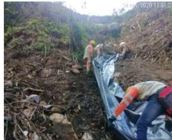
**Fotografía No 4.** Instalación plástico punto de Captación El Maco.
