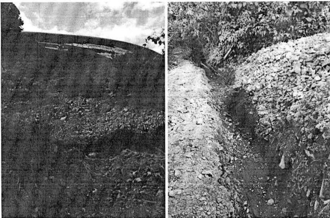
Daño de cuerpo de agua, que abastece a propietarios RUPA 3-0333 y otros
