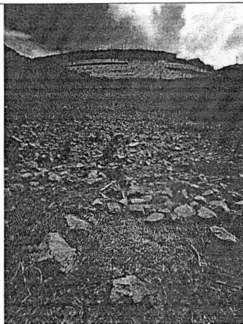
Improductividad del Predio por la existencia de rocas caídas del deslizamiento del CO 305
