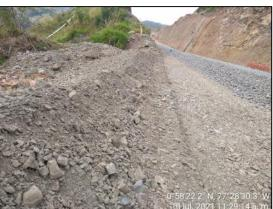
Hacia los taludes de corte CO219 y CO220 no se observan grietas de tracción, desplazamiento en masa, fracturamiento de materiales con continuidad o quiebre de estructuras, siendo estos indicios de inestabilidad en el talud; por lo cual se consideran que lo taludes dentro del tramo estudiado son estables bajo las condiciones actuales de conformación, materiales y acción de terceros.
