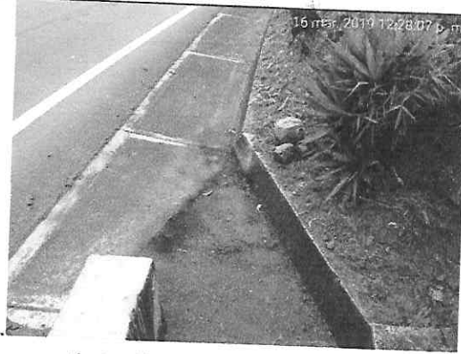
Ilustración 1- Entrada de Alcantarilla
