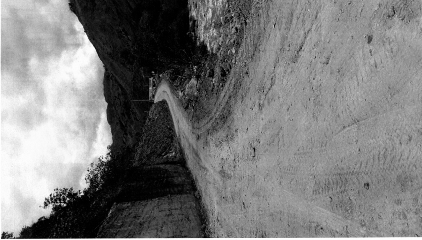
Muro de contención con las siguientes medidas: 20 mts de largo, 5 mts de largo, 50 cms de espesor en la parte superior y 80 cms de grueso en la parte inferior.
