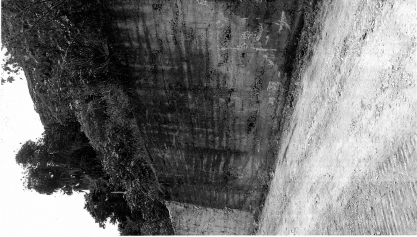
Muro de contención con las siguientes medidas: 20 mts de largo, 5 mts de largo, 50 cms de espesor en la parte superior y 80 cms de grueso en la parte inferior.
