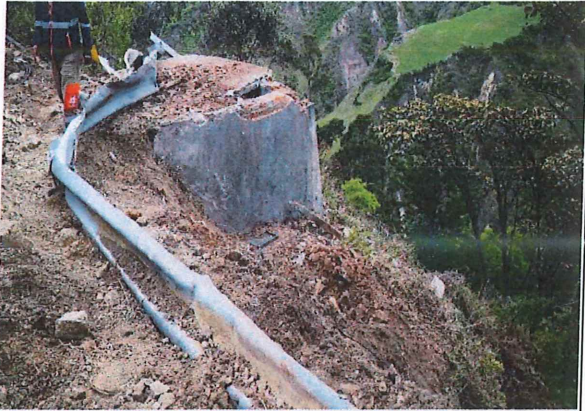
El tanque de abastecimiento de agua del sector la esperanza, en tablo bajo se observa construido en mampostería de ladrillo, terminado en su exterior con repello.
