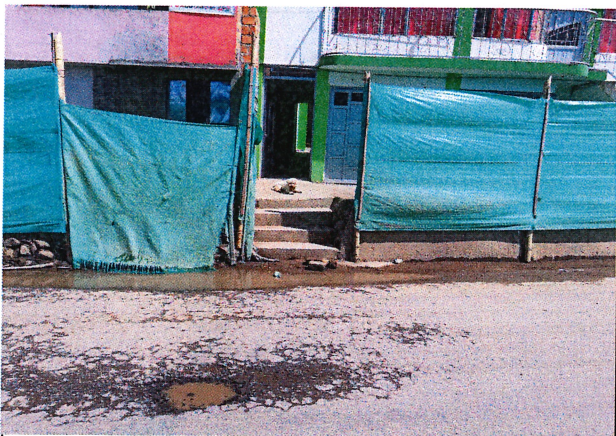
Nos refiere que los arrendatarios de su predio le presentan quejas por el difícil acceso.
