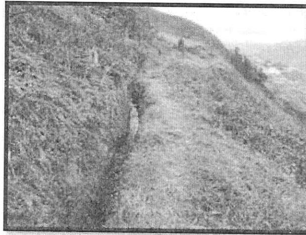
Así mismo, para minimizar los impactos asociados a la caída de materiales de excavación se realizó la instalación de barreras físicas (Trinchos) con malla triple torsión, los cuales permiten retener el material sobrante que pueda deslizar sobre el talud por la actividad de excavación.
